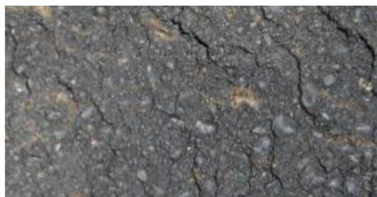
Рис. 6. Разрыв среды под жестким вальцом, формирование трещин
