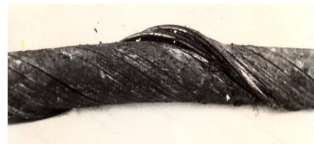
Рис. 9. Выход из замка наружных проволок несущего каната
