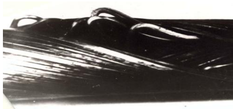
Рис. 11. Выдавливание (выпучивание) проволок нижележащего слоя несущего каната
