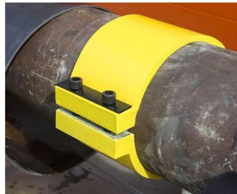
Рис. 3. Муфта стягивающаяся стальная, установленная на газопровод
