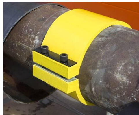
Рис. 3. Муфта стягивающаяся стальная, установленная на газопровод
