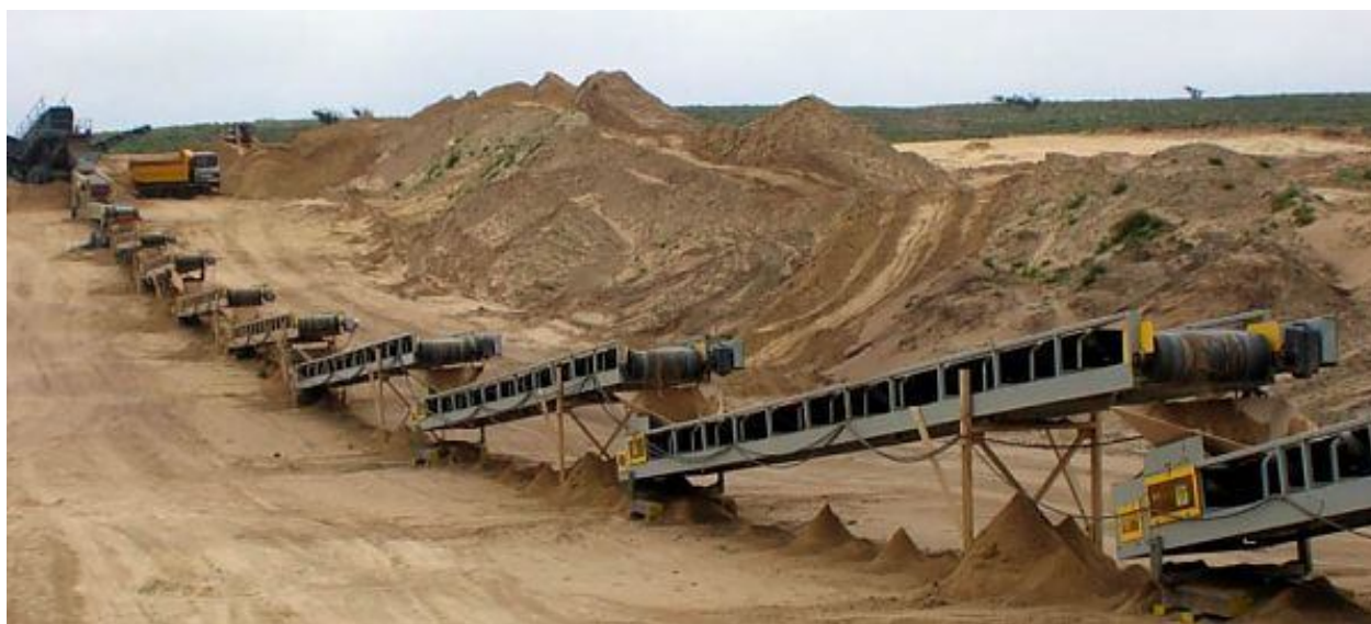
Рис. 1. Каскад коротких ленточных конвейеров
