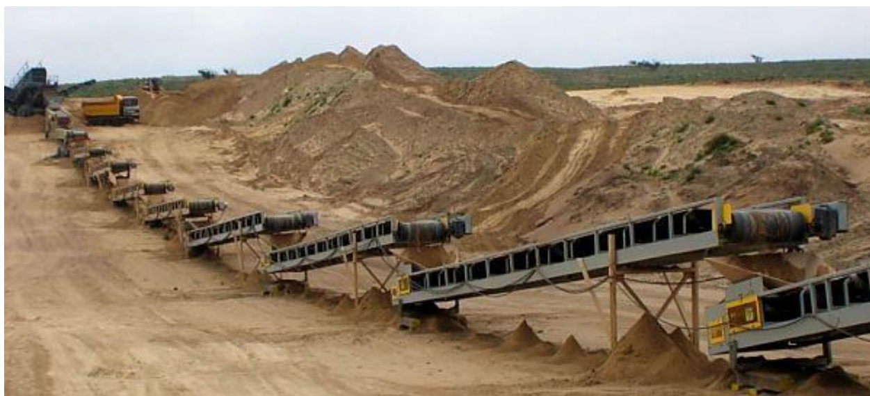
Рис. 1. Каскад коротких ленточных конвейеров
