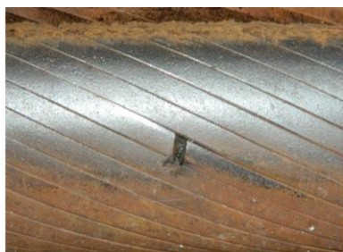
Рис. 8. Обрыв фасонной проволоки несущего каната закрытой конструкции
