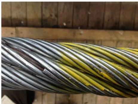
Рис. 1. Обрывы наружных проволок несущего каната
