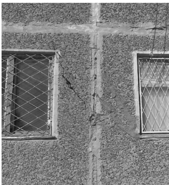
Рис.3. Сквозные трещины в стеновых панелях эксплуатируемых жилых зданий
