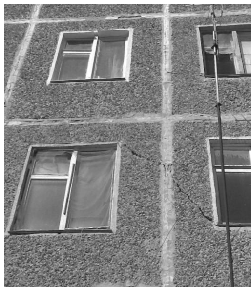
Рис.3. Сквозные трещины в стеновых панелях эксплуатируемых жилых зданий
