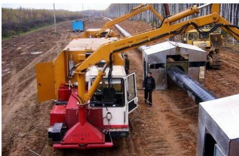
Рис. 7. Мобильная машина АСТ-4-А для сварки магистральных трубопроводов [31, 32]
