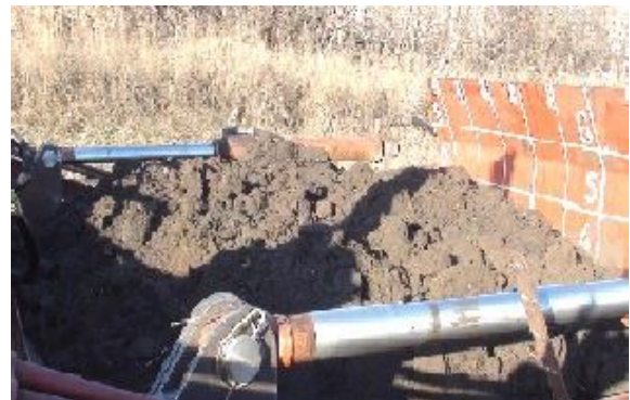
Рис. 7. Окончательное заполнение ковша (3 проход)
