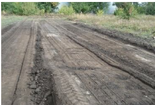
Рис. 6. Чистый, ровный забой после работы скрепера с комбинированной ножевой системой
